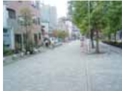
コミュニティ道路の整備
