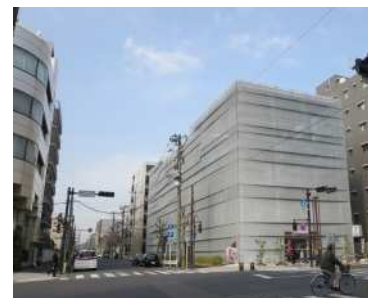
交差点からの見え方にや街並みに配慮した事例
