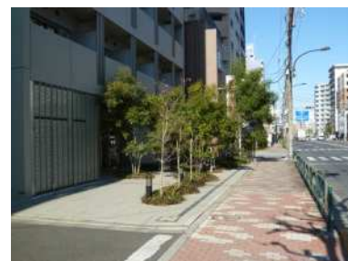
歩道と一体となった歩行者空間の事例
