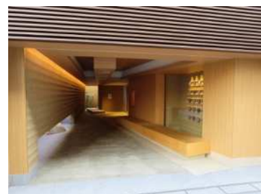
入口にガラス細工を飾り、さらに奥行きを感じさせるように工夫されたマンションエントランスの事例
