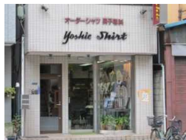
ショーウィンドウを設置した店舗の事例
