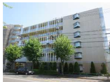
建築設備等が見えないように配慮されたマンション(他地区事例)
