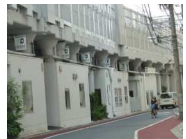
街並みを意識して間口が工夫された高架下の店舗（他地区事例）
