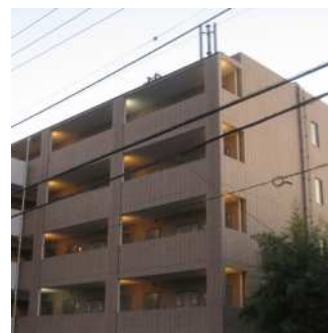
共用廊下の照明器具が直接見えないように工夫されたマンション (他地区事例)
