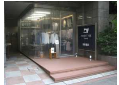
壁面後退し歩道と連続した空間を確保しつつ、ものづくりの技術をディスプレイしている事例
