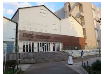
大横川親水公園に面してテラス等を設けた店舗(他地区事例)
