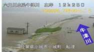
⑨牛津川の浸水被害 (佐賀県小城市)
