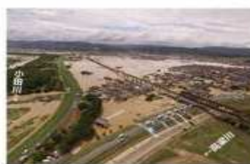
⑥小田川における浸水被害 (岡山県倉敷市)
