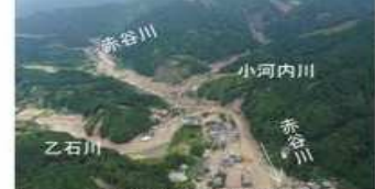
④赤谷川における 土砂・洪水氾濫及び流木による被害 (福岡県朝倉市)
