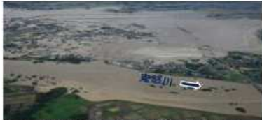
①鬼怒川における浸水被害 (茨城県常総市)
