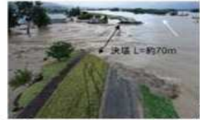
⑪千曲川における浸水被害 (長野県長野市穂保地先)
